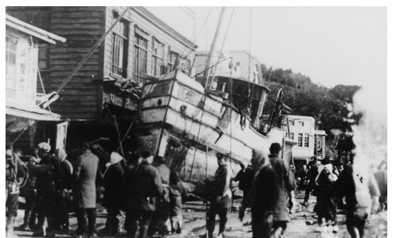
昭和三陸地震津波写真（鎌ヶ崎海岸通に打ち上げられた冷蔵運搬船 提供：宮古市災害資料アーカイブ）
